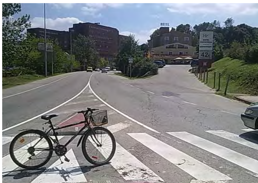
Figura 3: Aquí haurà d'haver el ramal que ha de connectar, segons l'esborrany del PMU 2014, amb el nou carril bici, ja realitzat, a l'Av. França (davant hospital Josep Trueta). Manca la connexió amb els barris de l'oest de la ciutat (Fontajau, Taià, Sant Narcís, Santa Eugènia).
