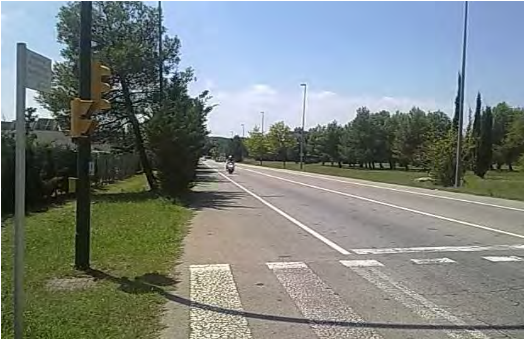
Figura 10. La resta de l'Avinguda Josep Tarradellas permet la creació d'un carril bici amb gran facilitat: pintura i separadors sobre el terra
