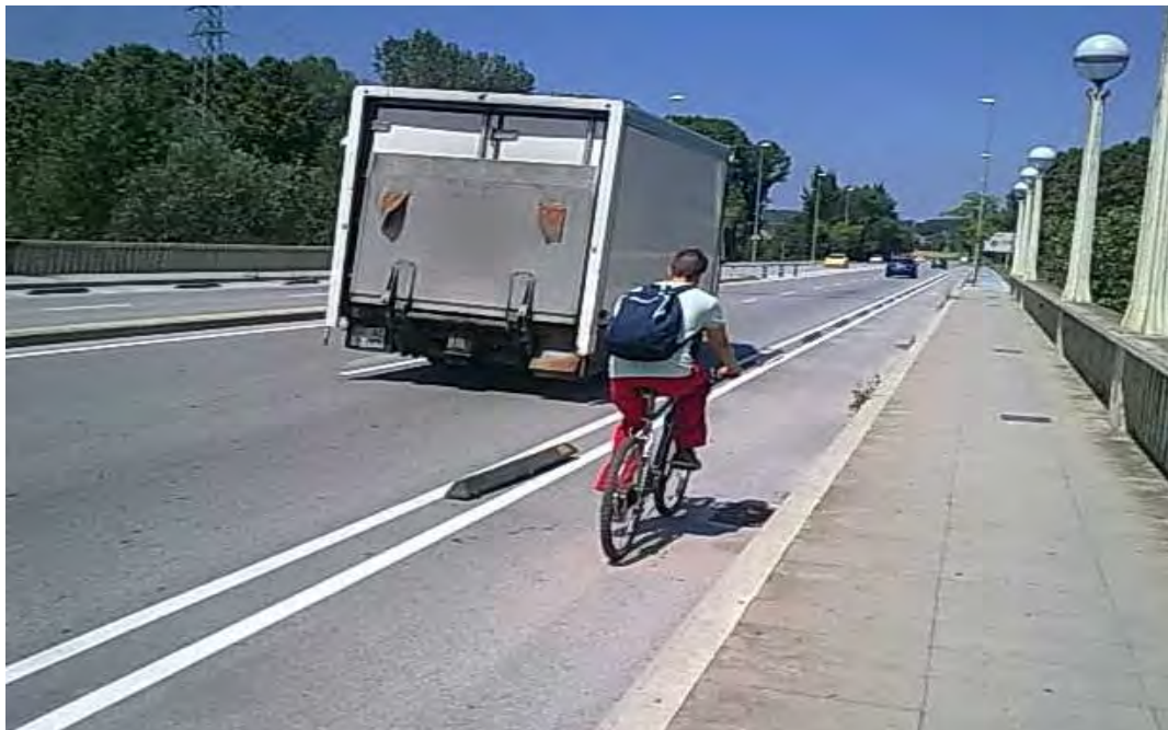
Figura 16. Carril actual Av. Josep Tarradellas. Observem com manquen separadors i d'altres estan malmesos i han perdut els reflectors.
